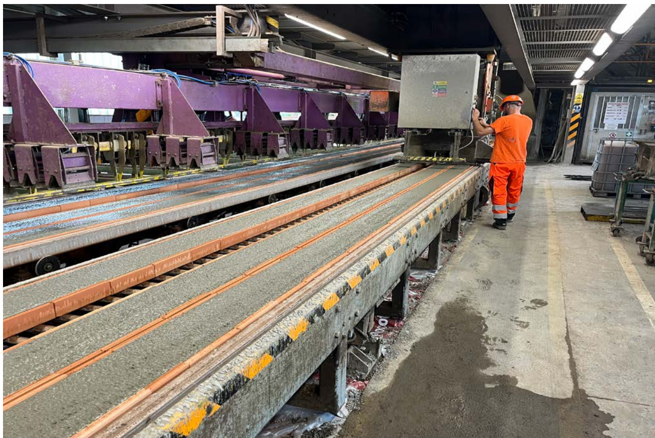
Foto 2: Zalévání čerstvým betonem
