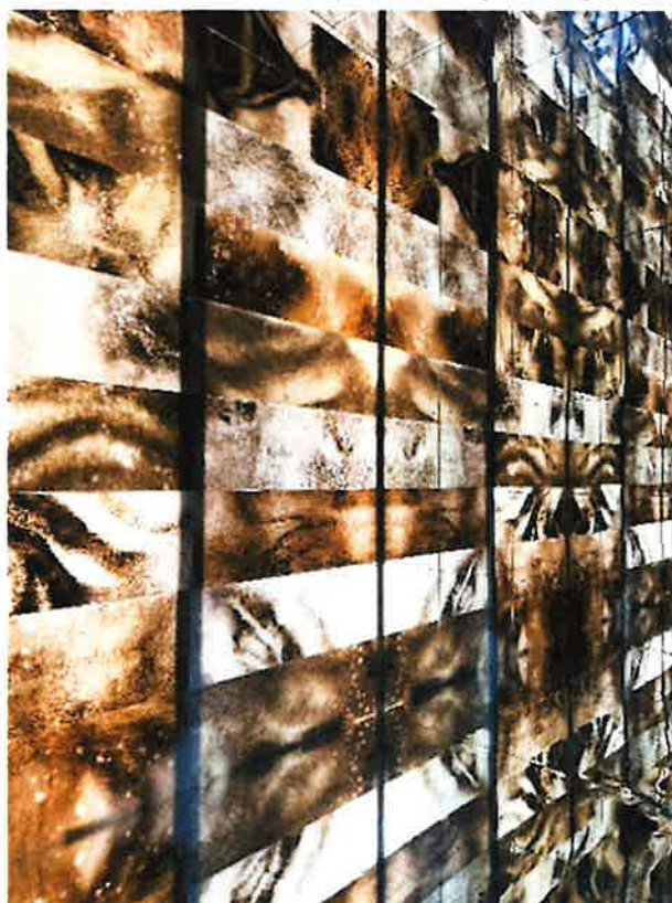
Obrázek 2: Recyklované podsvícené panely z kávového odpadu a recyklovaného plastu, vytvořené ve spolupráci se společností Starbucks- typ Onyx
