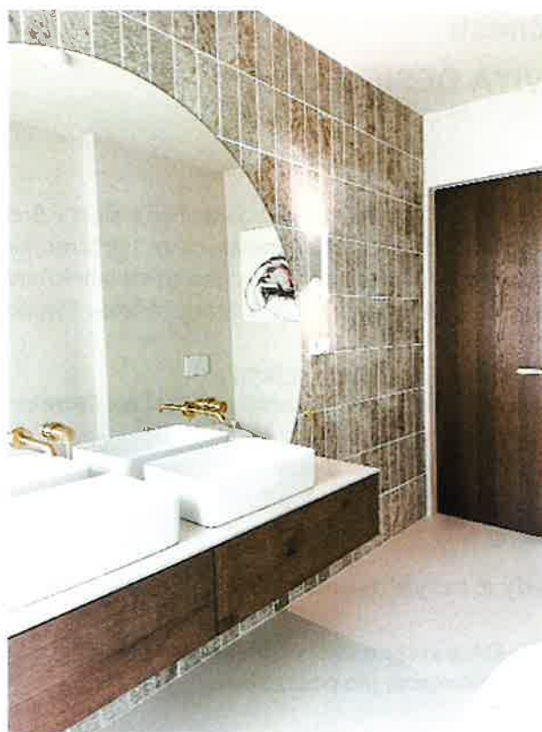
Obrázek 1: Koupelnové obklady vyrobené ze starých plastových kanystrů – typ Travertine
