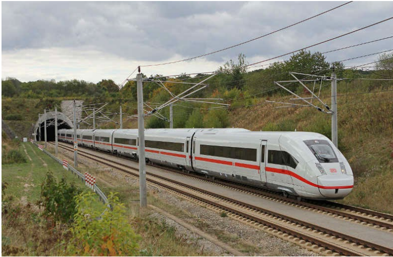
Obrázek 2: Širokopatní kolejnice 60E2 (Německo), společnost Deutsche Bahn
